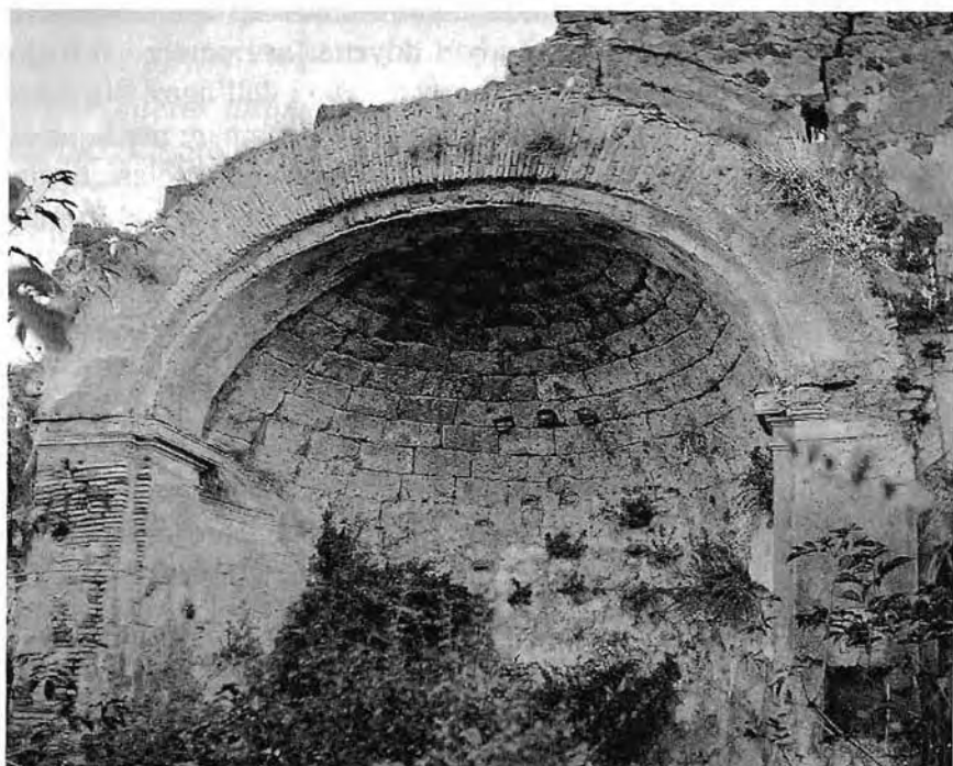
Particolare dell'abside, ormai crollata, della cattedrale alto-medievale di S. Maria a Monterano (Canale Monterano).
